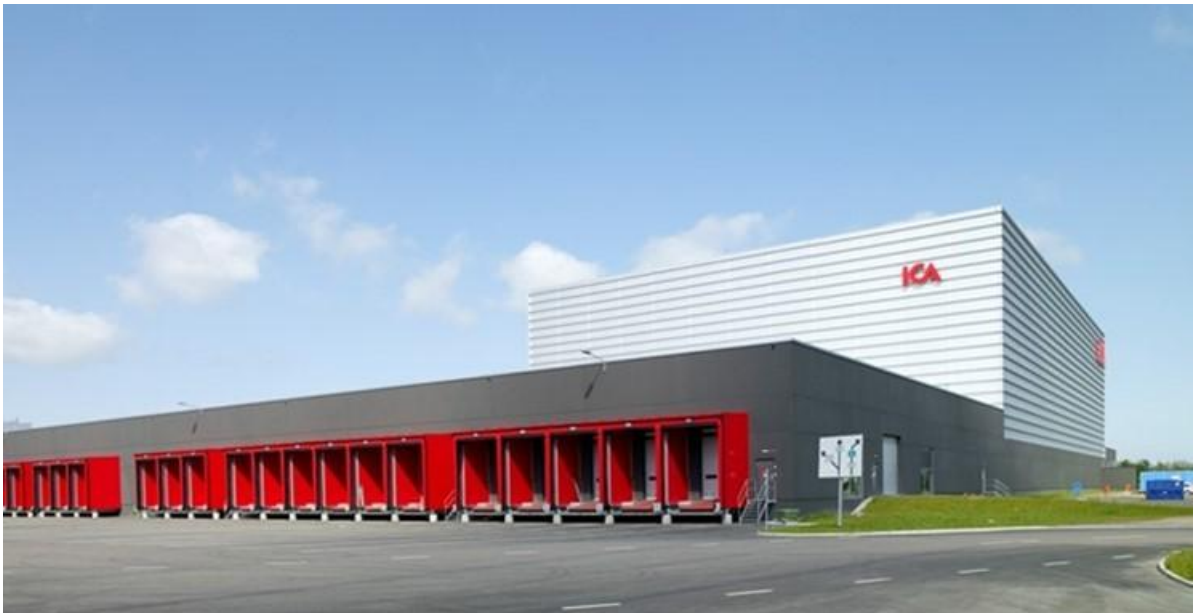
Figur 2.17: Nästan alla nya lager byggs med ändlastning som förutsätter att lasten kommer på trailer eller i container och inte i en konventionell järnvägsvagn. Bilden visar ICA:s nya lager i Västerås.
